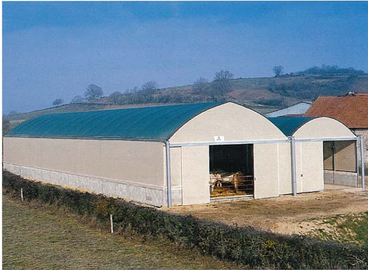
Stabulation de 640 m 2 (vue extérieure)
